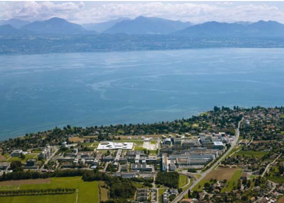
Vue aérienne du site de l'EPFL
