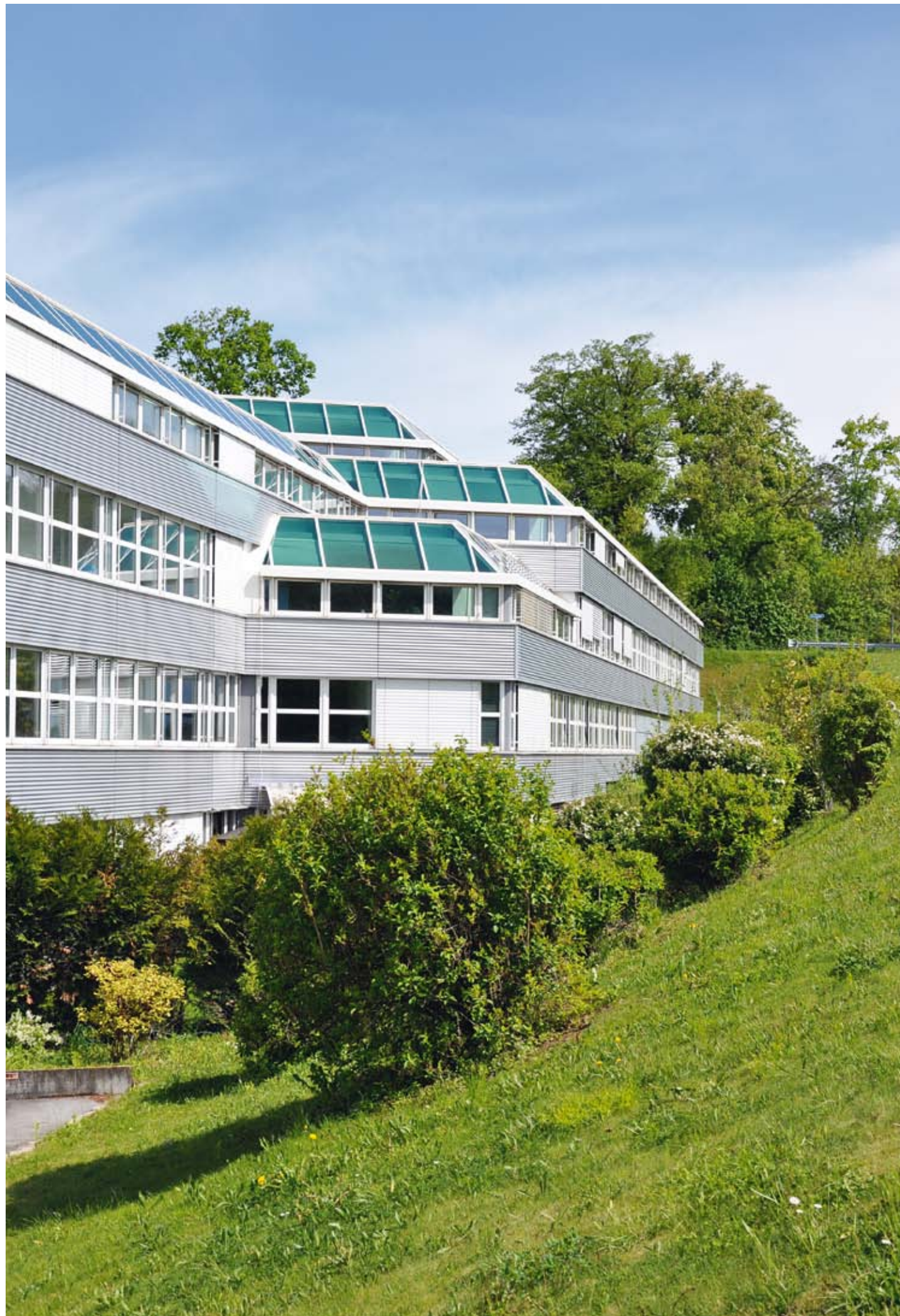
Bâtiment Victoria House
